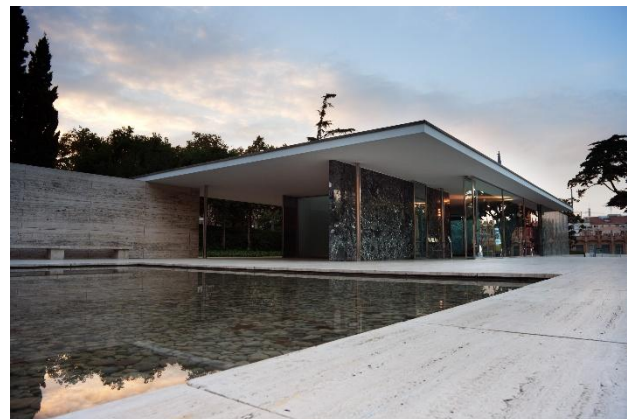
Der Pabellón Alemán von Mies van der Rohe
